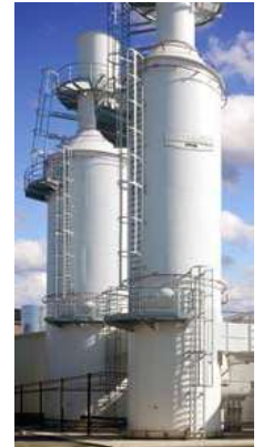
Achenbach Airpure Abluftreinigungssystem zum energieoptimierten Abscheiden und Rückgewinnen von Walzöl aus der Walzwerkabluft
